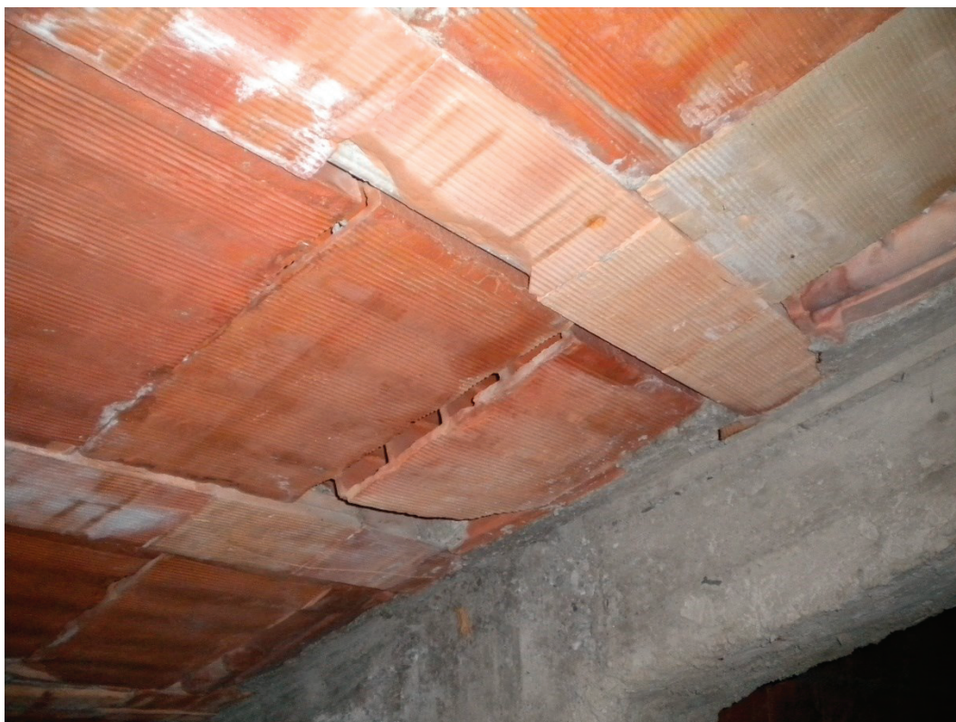
Fig. 4.10 – Particolare dello sfondellamento dei laterizi
