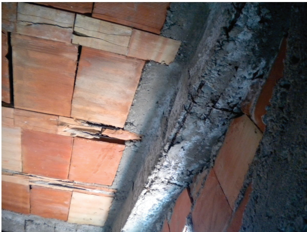
Fig. 4.11 – Particolare del degrado della struttura di copertura
