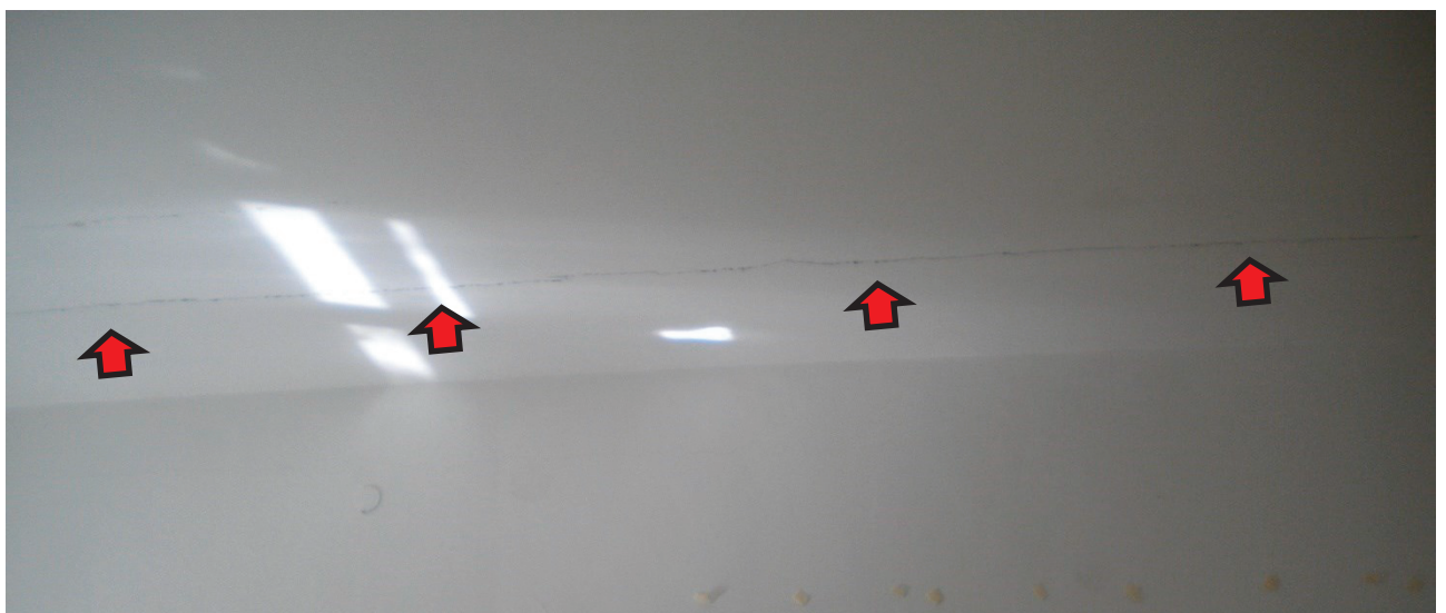
Fig. 4.7 – Lezione sul solai di copertura del piano primo
