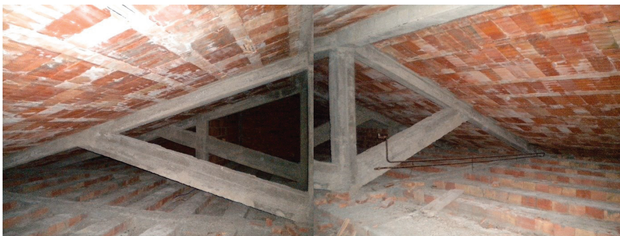
Fig. 4.9 – Struttura reticolare di sostegno della copertura
